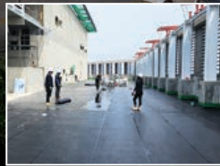
옥탑층 방수시트 시공
