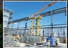
옥상층 헬리패드 철골 조립
